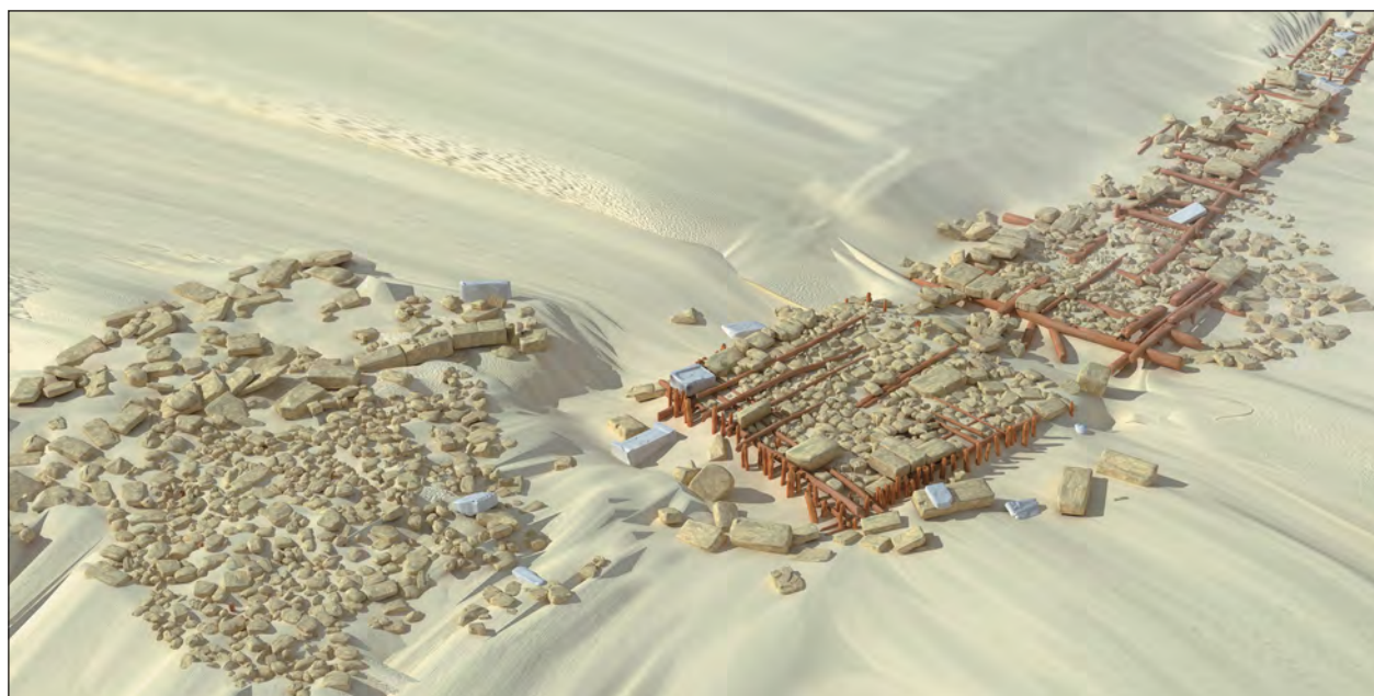
3D-реконструкция фундамента-ряжа портового сооружения.
