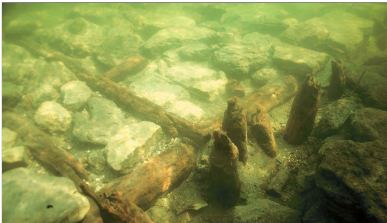
Деталь подводного фундамента, сооруженного из дубовых бревен и камня.
